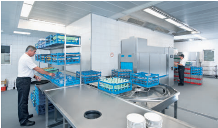
Meiko-Spülanlage im Hotel Bell Rock im Europapark in Rust.
